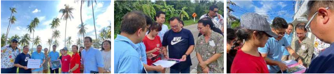
กทพ. และที่ปรึกษา ลงพื้นที่ตรวจสอบแนวสายทางเลือกในพื้นที่อำเภอเกาะสมุย จังหวัดสุราษฎร์ธานี เมื่อวันที่ 3 พฤศจิกายน 2566
